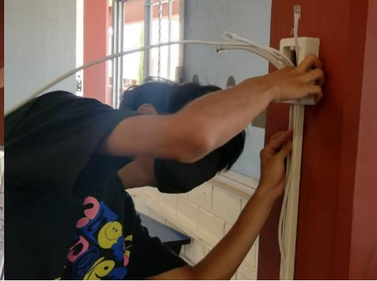
6. Instalando el cable
